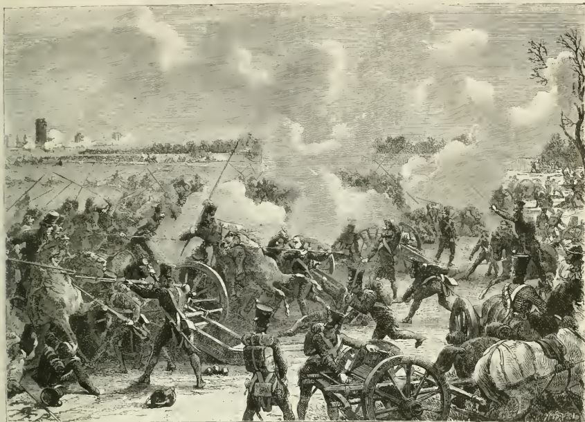
L'École polytechnique sur l'avenue de Vincennes
